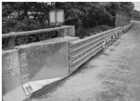
图 7 钢结构翼墙过渡段护栏完工现场图
