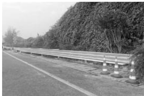
图 6 端部外展护栏完工现场图
