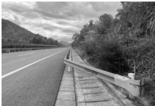
图1 外展端头“一板跨沟”、斜率较大情况实拍图
